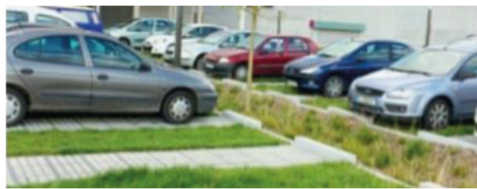
Noue végétalisée avec infiltration gravitaire du ruissellement
