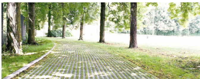
Revêtement de circulation douce semi-perméable
